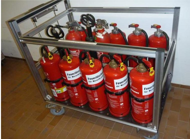
Ein Rollcontainer mit **Sonderlöschmittel** enthält 5x 12kg-Metallbrandlöscher, 5x 12kg-Pulverlöscher und 2x 5kg-CO2-Löscher (Lager).
